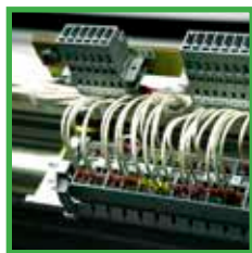
Armarios eléctricos y subestaciones
