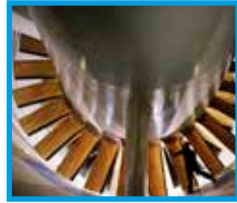
SALAS DE TURBINAS
